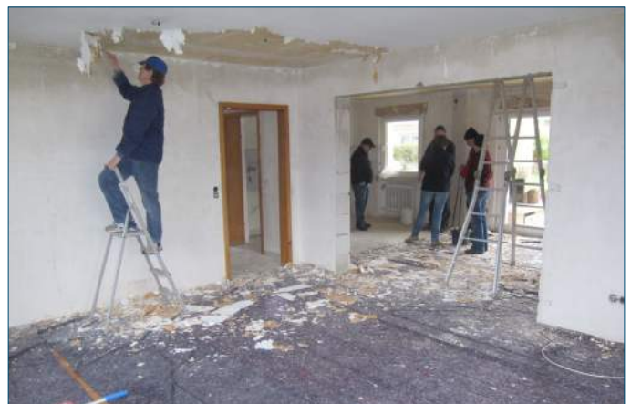
Freiwillige bei Renovierungsarbeiten im Pfarrhaus, Foto: T. Roth
